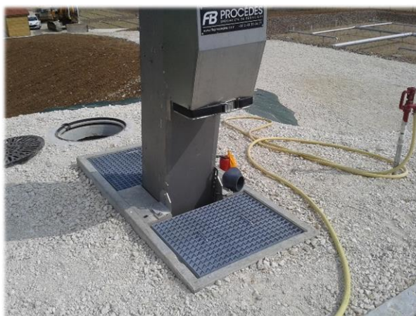
Photographie 4: Exemple de dégrilleur automatique installé dans un canal béton (avec by pass)
