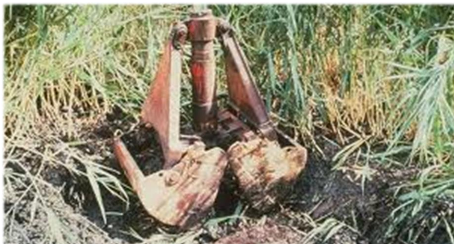
Figure 38 : Curage d'un massif filtrant (1 er étage)
