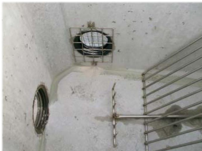
Photographie 3: Exemple de dégrilleur béton (avec by pass)
