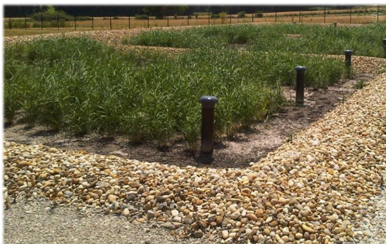
Photographie 2: Exemple de massif filtrant (1 er étage)
